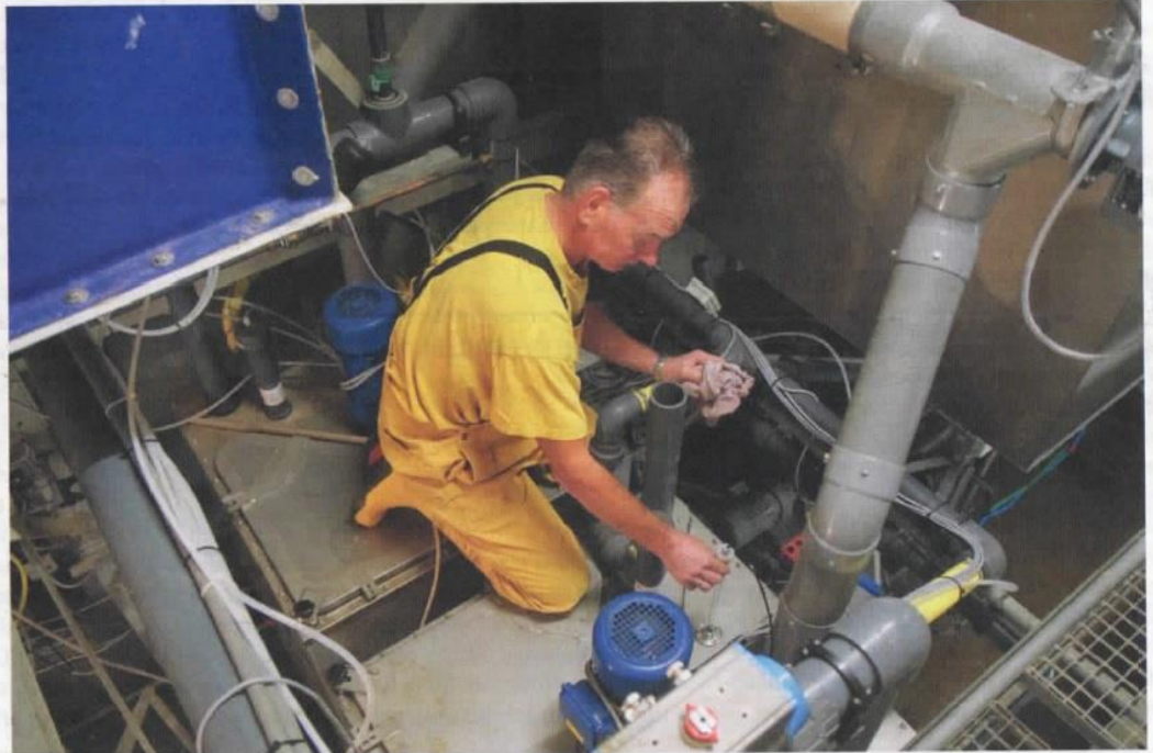
Michel van den Bergh installeert een UV-C-licht in een voermenger.
